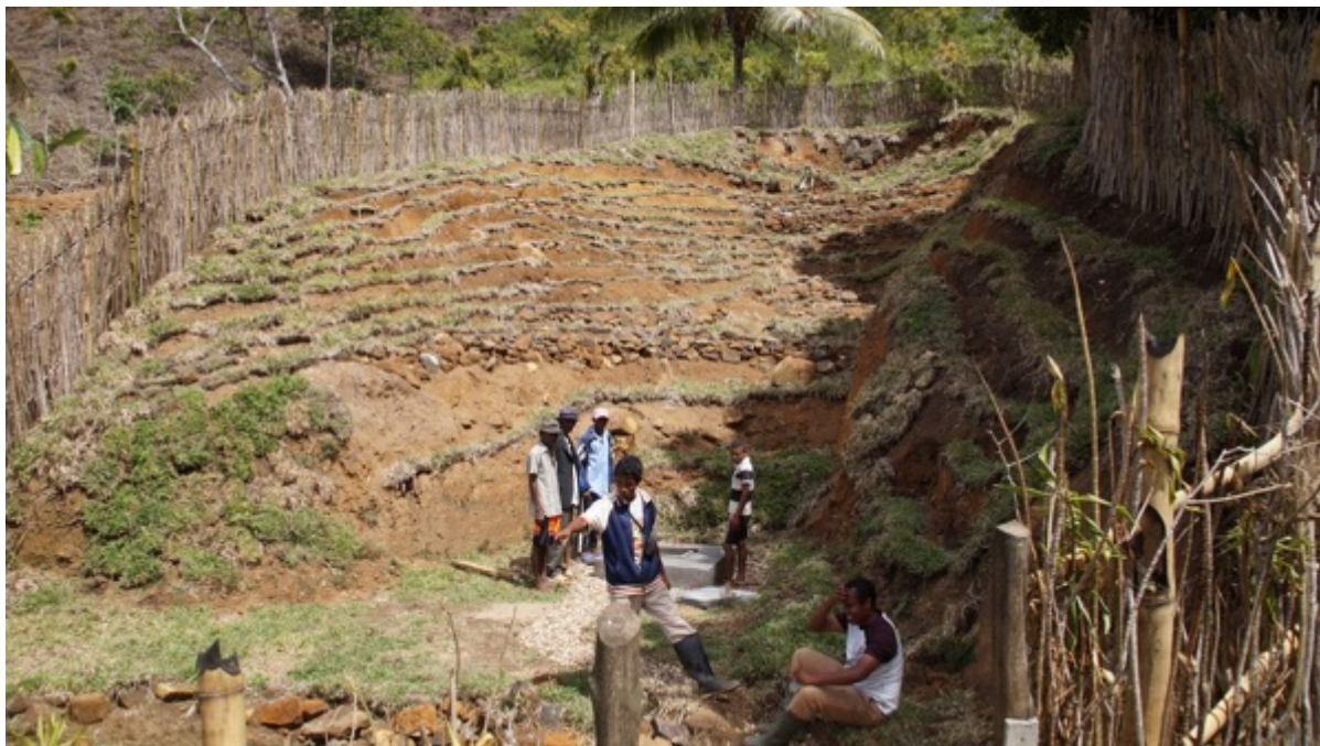
Périmètre de protection source Ambatobe-Anjiro lors de la réception provisoire des travaux
