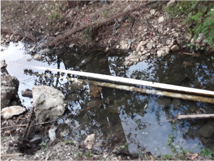
Figure 11 : A gauche : adduction et trop pleins non protégés ; A droite : Evacuation de l'eau des trop-pleins
