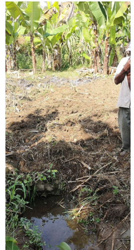
Figure 6 : Trop plein à quelques dizaines de mètres de la sortie de la boîte de captage
