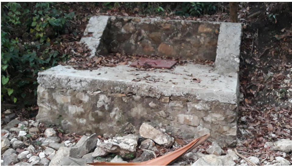
Figure 9 : A gauche : boite de captage ; A droite : ouverture de la boite de captage rendu difficile
