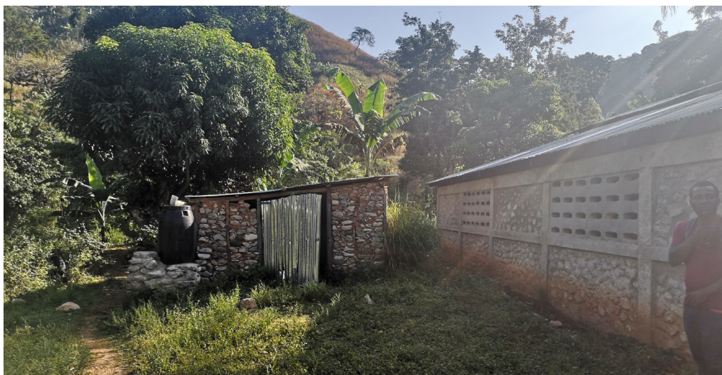
Figure 6 : Toilette de l'école de Demahague
