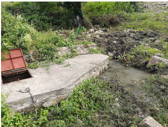
Figure 1 : A gauche : boite de captage vue d'en haut ; A droite : boite de captage vue du dessus ; sur les deux photos la présence de boue est remarquable
