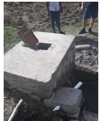
Figure 3 : Borne fontaine avec présence de boue aux alentours et des tuyaux PVC cassés
