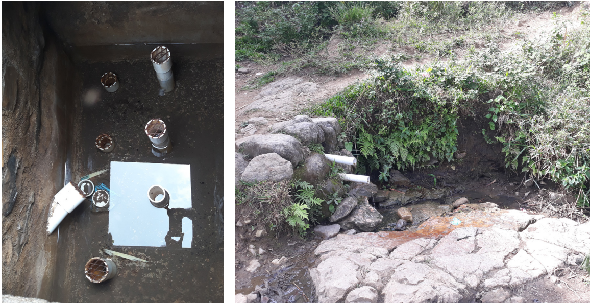
Figure 11 : A gauche : Intérieur de la boîte de captage, présence de rouille sur les grillages ; A droite : Evacuation de l'eau des trop-pleins
