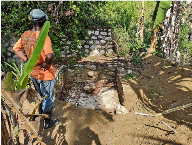
Figure 7 : A gauche : boîte de captage avec les problèmes de boue énoncés ; A droite : intérieur de la boîte de captage qui semble être nettoyée
