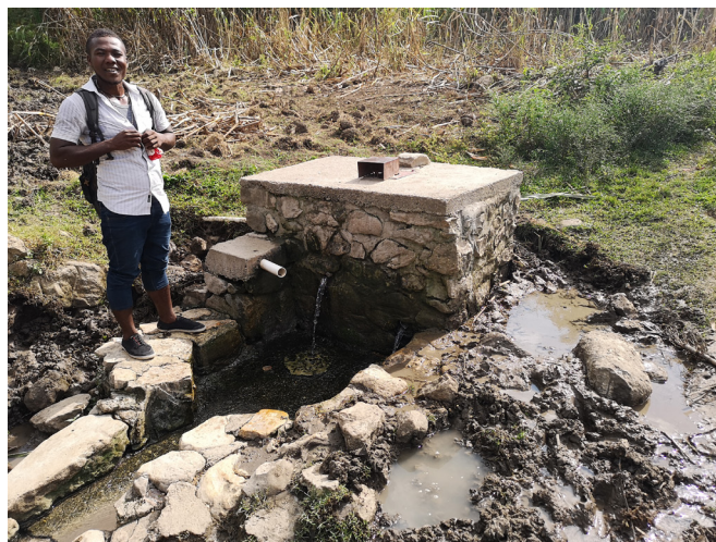
Figure 3 : Borne fontaine avec présence de boue aux alentours et des tuyaux PVC cassés
