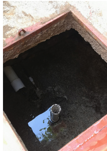
Figure 7 : A gauche : boîte de captage avec les problèmes de boue énoncés ; A droite : intérieur de la boîte de captage qui semble être nettoyée
