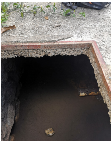
Figure 2 : Intérieur de la boite de captage, visiblement non entretenu
