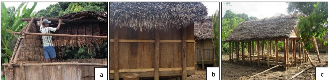
Figure 20 : Différentes parties des cases traditionnelles du sud-est malgache : remplacement des feuilles de ravenala du toit (a), panneaux en troncs de ravenala (b), structure de la case composée de piliers d'eucalyptus (c). Source personnelle.
