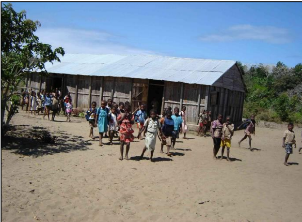
Nouveau bâtiment construit par les comités d'école avec le soutien du projet à Farafangana en 2010.
