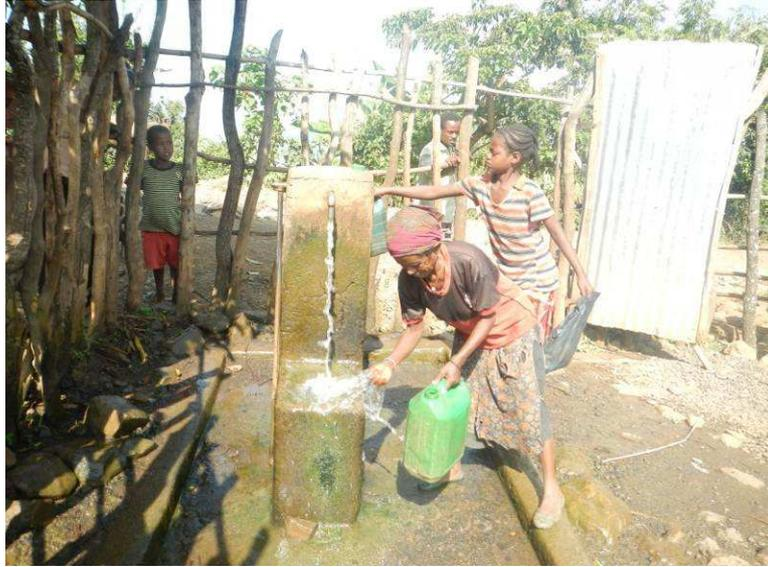
Exemple d'un point d'eau ancien, la margelle de récupération de l'eau n'était pas pratique, les femmes étant obligées de se pencher pour ne pas de mouiller les pieds, et le bloc pour poser le jerrican est un peu trop bas
