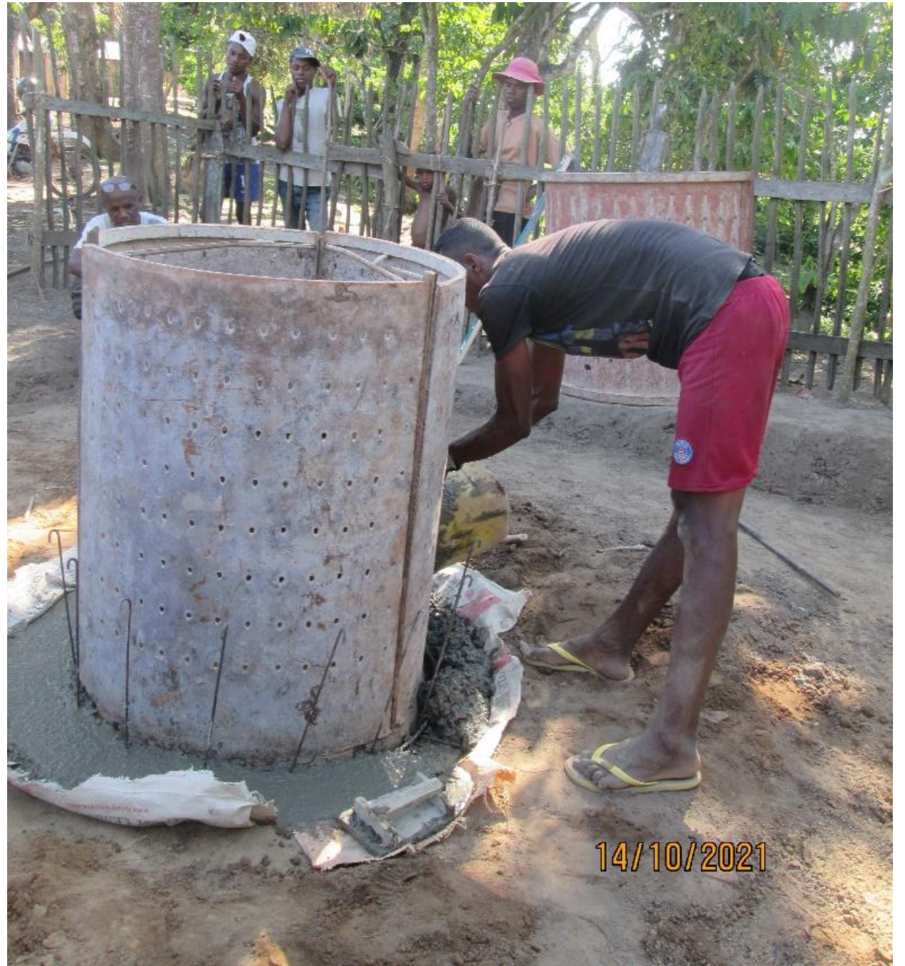
Photo 3 : Coulage de la trousse coupante
