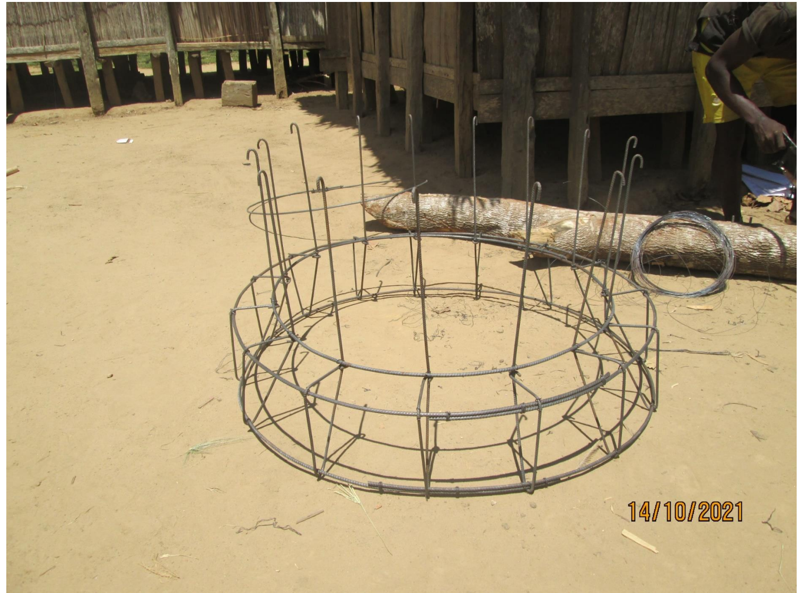
Photo 1 : Ferrailage de la trousse coupante
