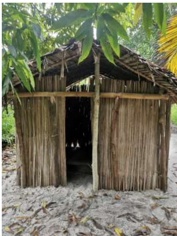
Latrine double-fosses à Tanambao, Analanjirofo
