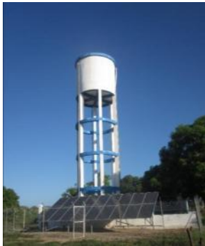
Figure 58 : réservoir et système d'énergie à Ambahikily
