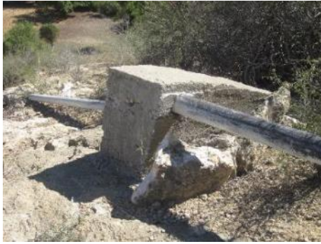
Figure 86 : Plot pour protéger une conduite hors sol
