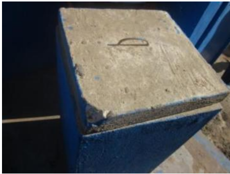
Figure 17 : Sécurisation du captage à Ambahikily
