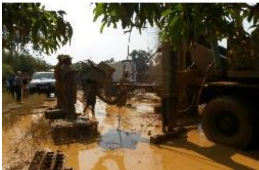
Figure 20 : Inondation suite à un fort débit et coincement des tiges par éboulement
