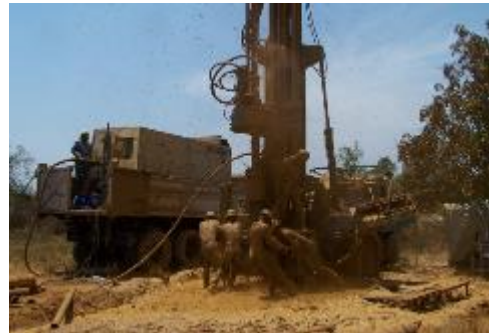
Figure 21 : Difficulté rencontrée de la descente des tubages en acier
