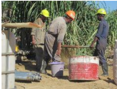
Figure 13 : Tamisage du sable pour la margelle en béton
