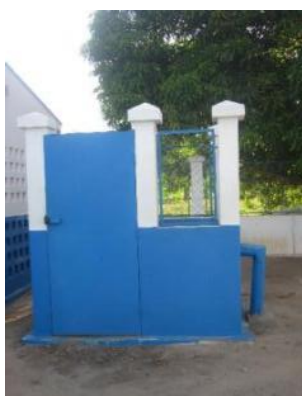
Figure 54 : Clôture à Ambahikily
