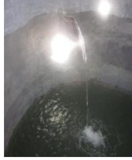
Figure 74 : Conduite de refoulement
