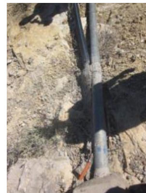
Figure 64 : Protection des câbles électriques
