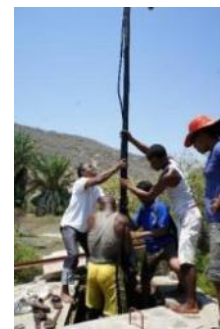
Figure 62 : Installation de la pompe à Saint Augustin
