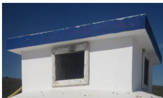
Figure 80 : Fenêtres du réservoir d'eau à Ambohimahavelona
