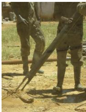
Figure 30 : Nettoyage du fond de forage avant
