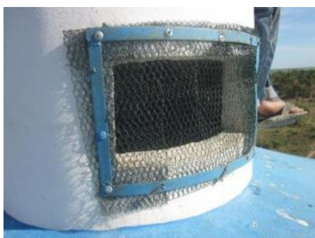
Figure 79 : Fenêtres du réservoir d'eau à Ambahikily
