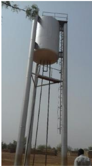
Figure 3 Château du réseau de La-Tôden (Burkina-Faso), 12000 habitants, géré par l'entreprise PPI-BF sous contrat d'affermage avec la commune. Extension du réseau soutenue par Experts-Solidaires, financement SEDIF.
