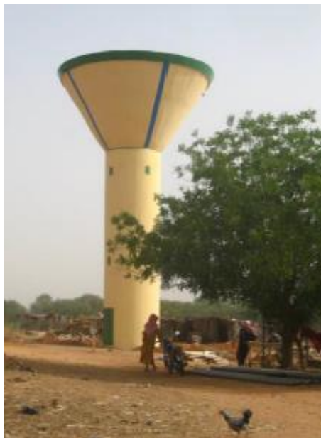
Figure 5 Château d'eau de Komodinde, Mali.
